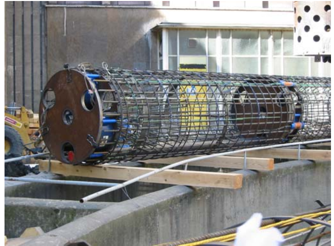
Bild 10: Foto des Bewehrungskorbes mit den zwei Pressenebenen vor dem Einbau
