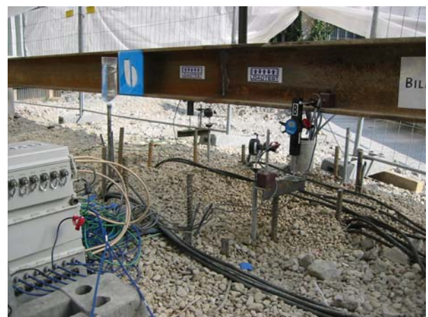
Bild 7: Versuchsaufbau der Pfahlprobelastung mittels Osterbergzellen beim Projekt FrankfurtHochVier
