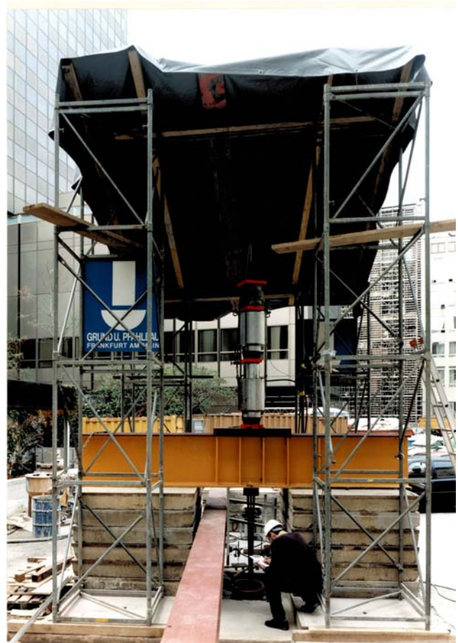
Bild 5: Versuchsaufbau der Probelastung beim neuen Commerzbank-Hochhaus
