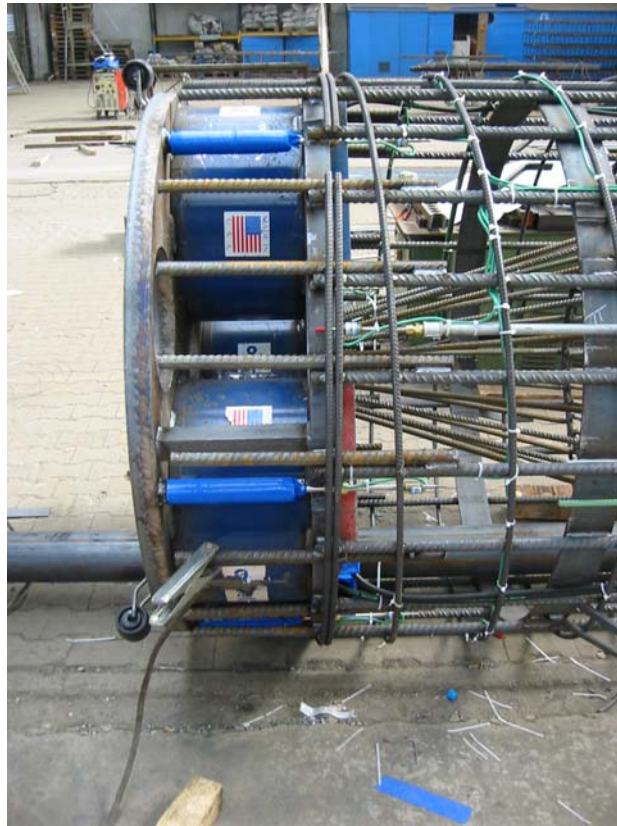
Bild 8: Foto der unteren Osterberg O-Zellenebene und des Köchers für das Betonierrohr
