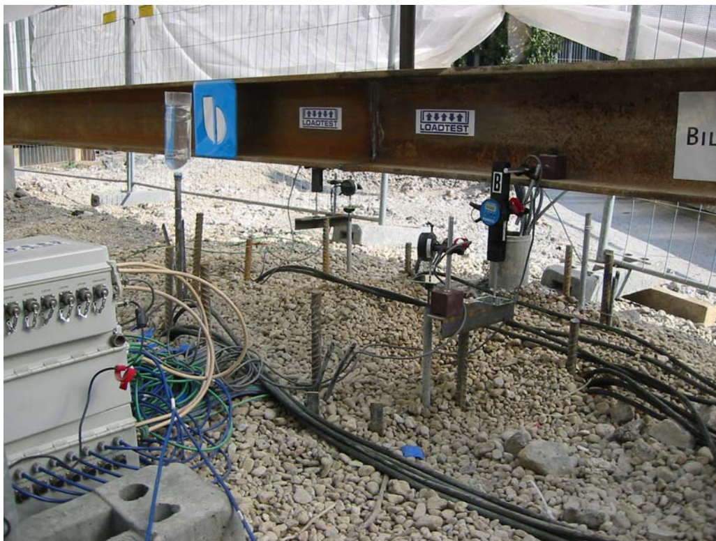
Bild 10: Versuchsaufbau der Pfahlprobelastung mittels Osterbergzellen beim Projekt FrankfurtHochVier
