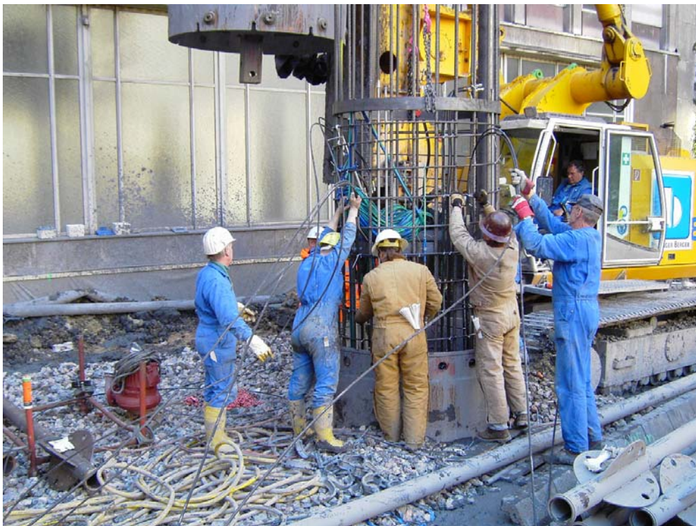
Bild 9: Versuchsaufbau der Pfahlprobelastung mittels Osterbergzellen beim Projekt FrankfurtHochVier
