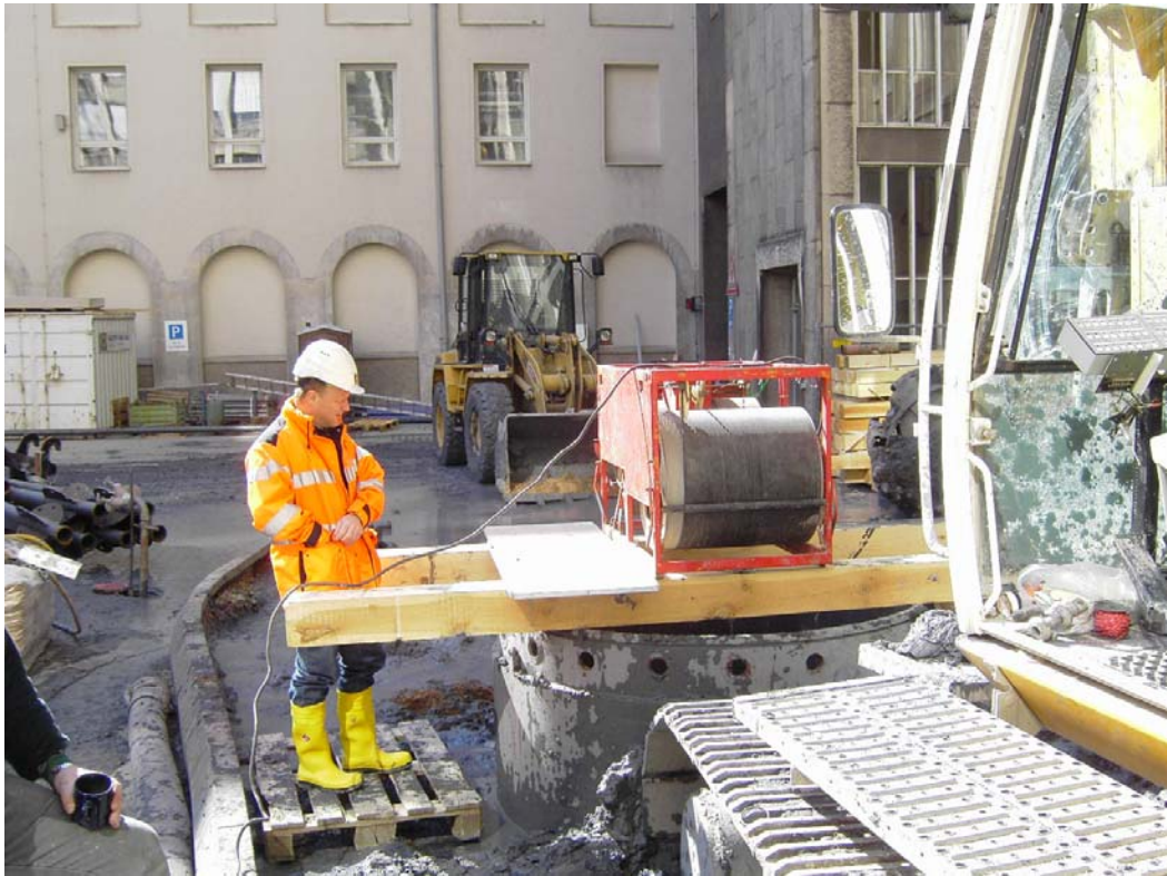
Bild 6: Vertikalitätsmessung mit dem Koden Drilling Monitoring
