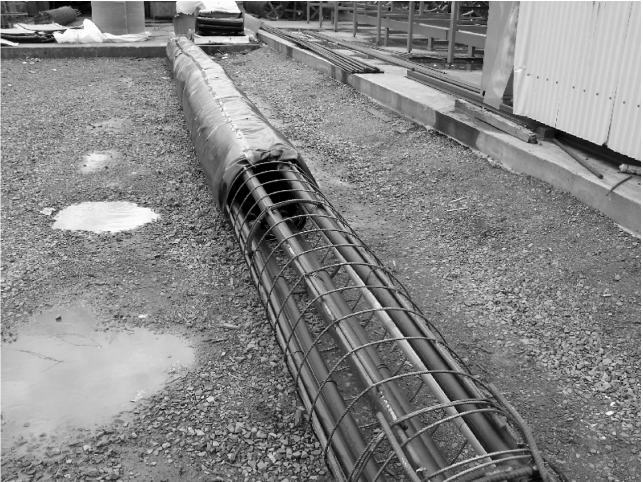
Bild 4: Pfahlkorb vor dem Einbau mit Membran im „Leerbohrbereich“
