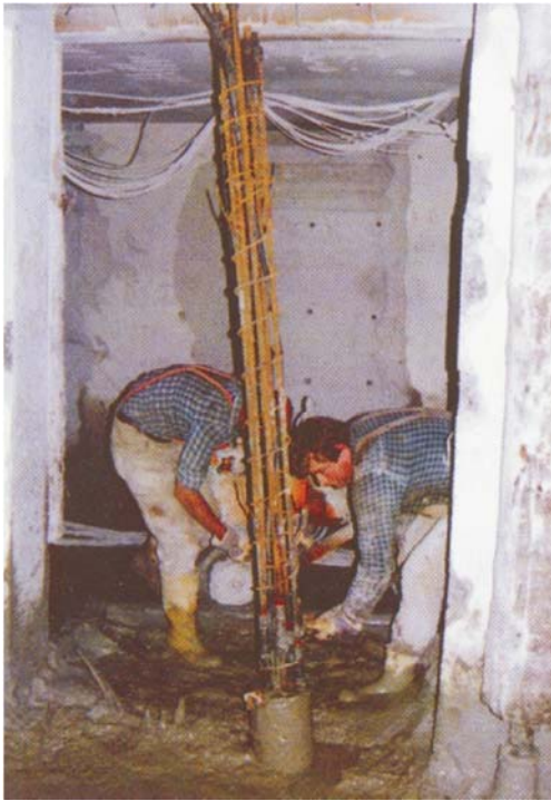
Bild 9: Unterfangung mit Verpresspfählen
