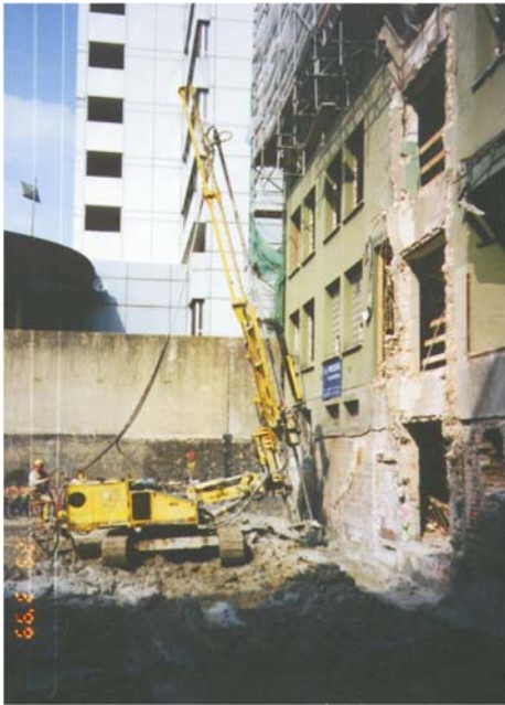
Bild 14: Abschnittsweises Herstellen der DSV-Säulen
